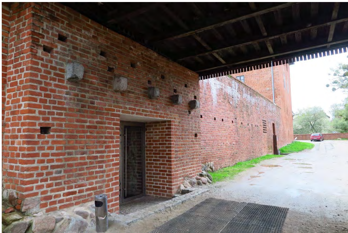
Mur przedzamcza od strony suchej fosy. Wtórne wejście do pomieszczeń kuchennych.
