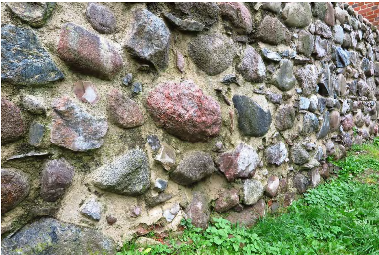
Zamek biskupów w Lidzbarku Warmińskim. Między murze część pd-wsch. Lokalizacja reliktyw skrzydła pałacu bp. A. Grabowskiego. Mur wschodni parhamu południowego.
