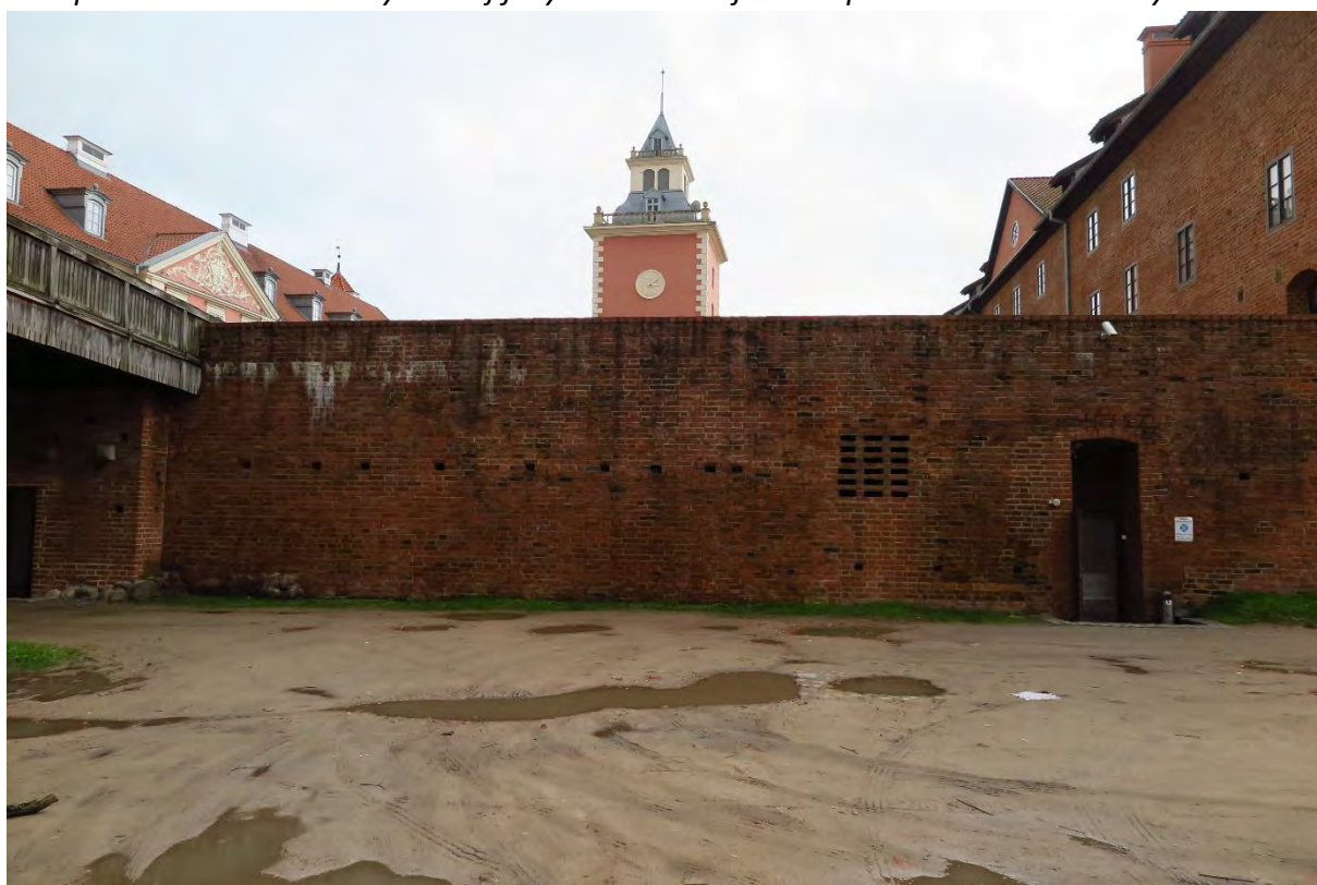
Mur przedzamcza od strony suchej fosy. Wtórne wejście do zaplecza magazynowego hotelu.
