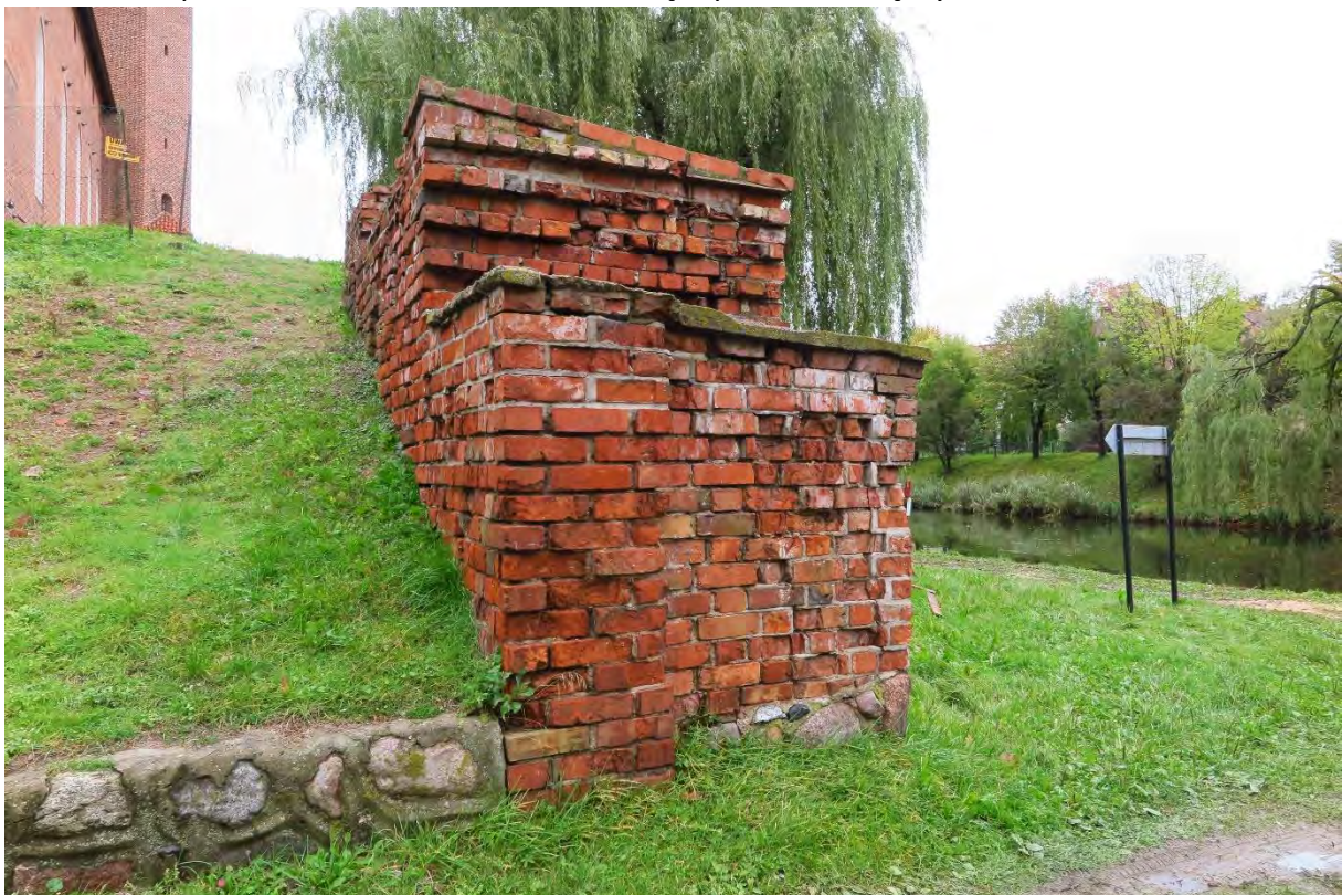
Zamek biskupów w Lidzbarku Warmińskim. Mur wschodni. Przejazd bramny.
