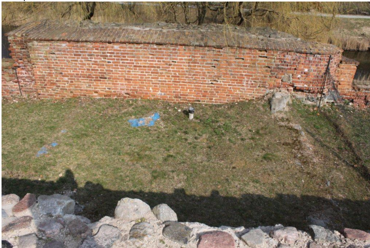
zdjęcie 3 - Międzyzmurze Wschodnie, obszar posadowienia reliktyw aneksu pałacu na parchamie południowym
